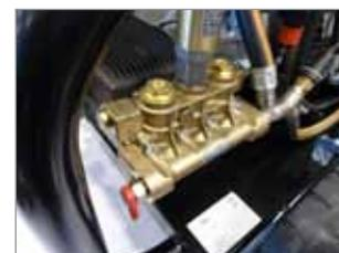
VÁLVULA TERMOESTÁTICA PARA PROTEÇÃO DA BOMBA CONTRA SOBREAQUECIMENTO
